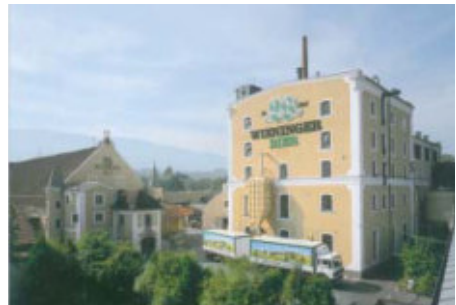
Teil des Betriebsgebäudes der Privatbrauerei M.C. Wienerer GmbH & Co.KG in Teisendorf
