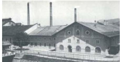
Das Salinengebäude auf der Pernerinsel in Hallein (um 1948)
