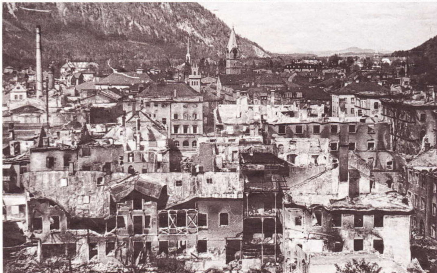
Das Kammerbotenviertel nach dem Bombenangriff am 25. April 1945.
