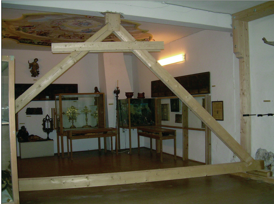
Mit massivem Balkenfachwerk wird die Statik des Gebäudes derzeit gesichert.
