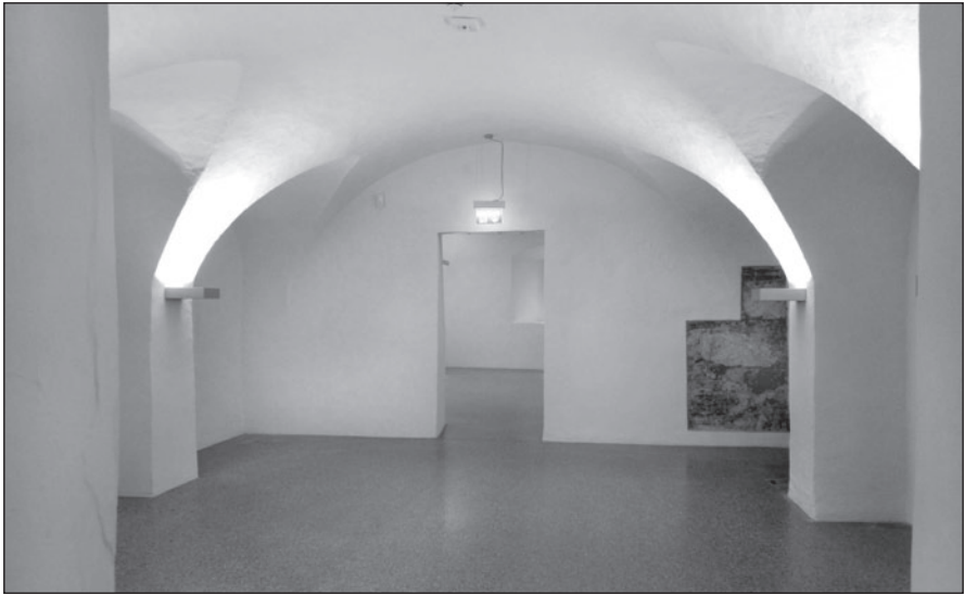
Ein wichtiges Detail dieses Fotos ist der unverputzte Wandteil rechts der Bildmitte. Bei dieser „Bausignatur“ sind Teile einer früheren Außenmauer zu erkennen. Bildnachweis: Stadtbaumeister Thomas Knaus
