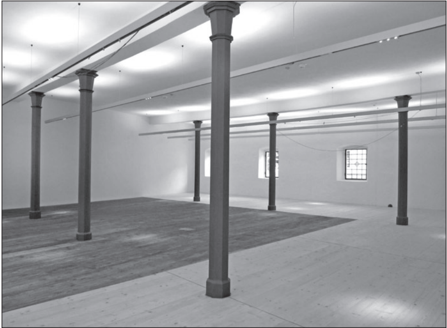
Blick in die östliche Halle im ersten Obergeschoss. Der dunkle Boden stammt aus dem Bestand, der hellere ist ein neuer Fichtenboden. Bildnachweis: Stadtbaumeister Thomas Knaus
